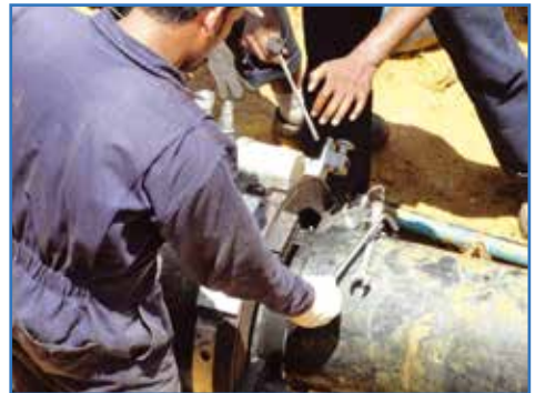
Einsatz auf der Baustelle
