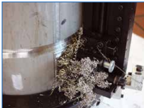
Entfernung der Längsschweißnaht
