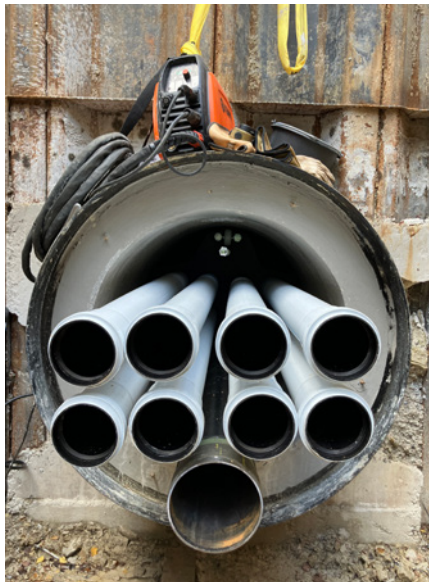
Bild 2: Neubau Strecke UW „Kistlerhofstraße“ – UW „Hadern“ mit Unterquerung der Autobahn A95
