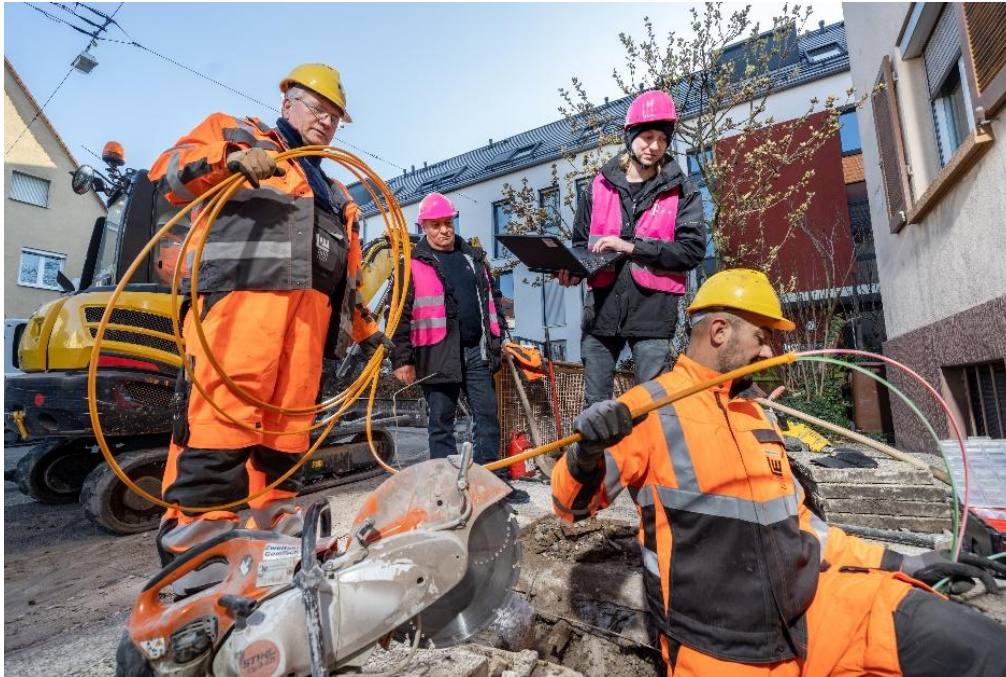
In Deutschland baut die Deutsche Telekom ihr Glasfasernetz weiter aus. Das Bild zeigt einen Baubegleiter der Telekom, der die Fortschritte an einer Glasfaser-Baustelle überprüft. / Foto: Deutsche Telekom
