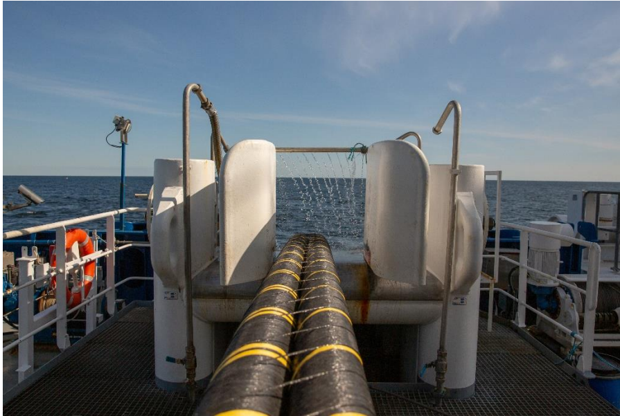
Meter für Meter sinken die Seekabel der NordLink ins Meer. ©TenneT
