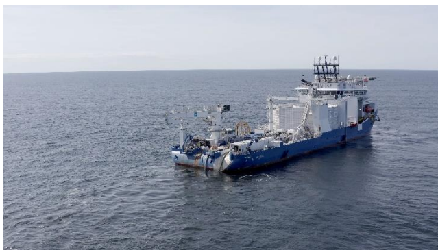
Vom Schiff aus werden die Seekabel für die NordLink verlegt. ©TenneT
